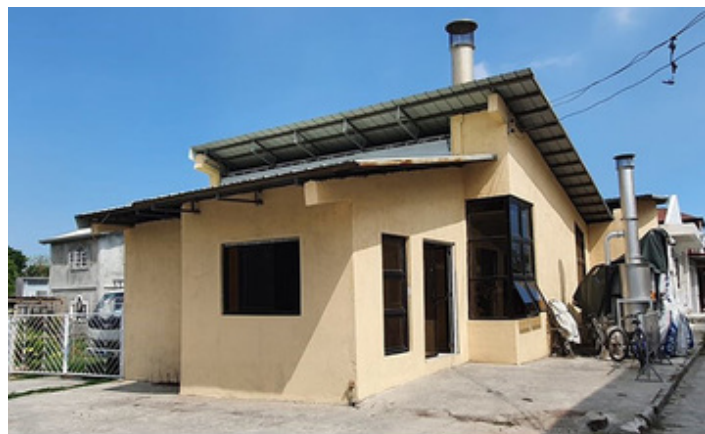
木下築炉が民間霊園と組んで建てたカビテ州タンザの火葬場（同社提供）
