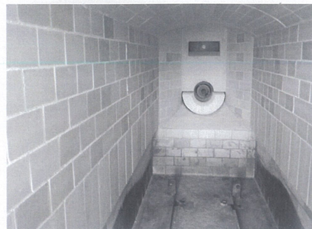
大分市佐賀関斎斎場の火葬炉も木下築炉の工事実績の一つ
