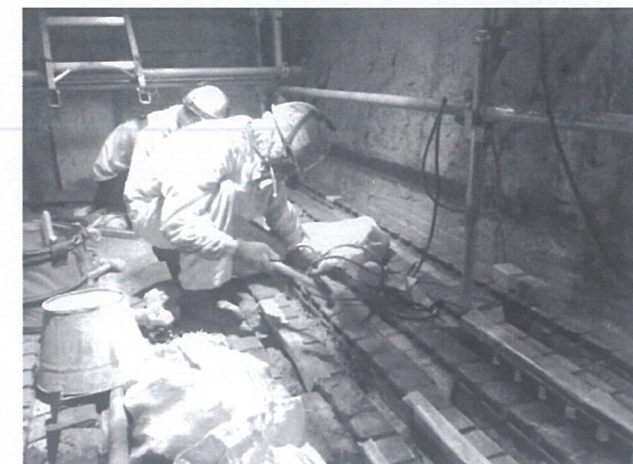
炉内耐火レンガの張り替えは国家資格を持つ職人の仕事
