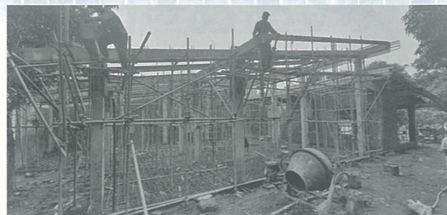
フィリピンで建設中の火葬炉施設 Heaven Memorial Park
